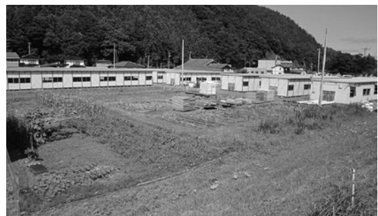
仮設住宅用地の現状復旧の状況
